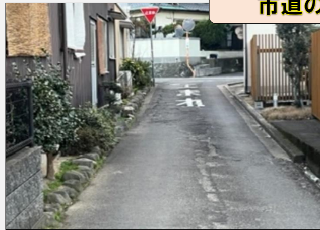
市道の舗装整備
