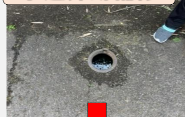
水道弁跡補修
